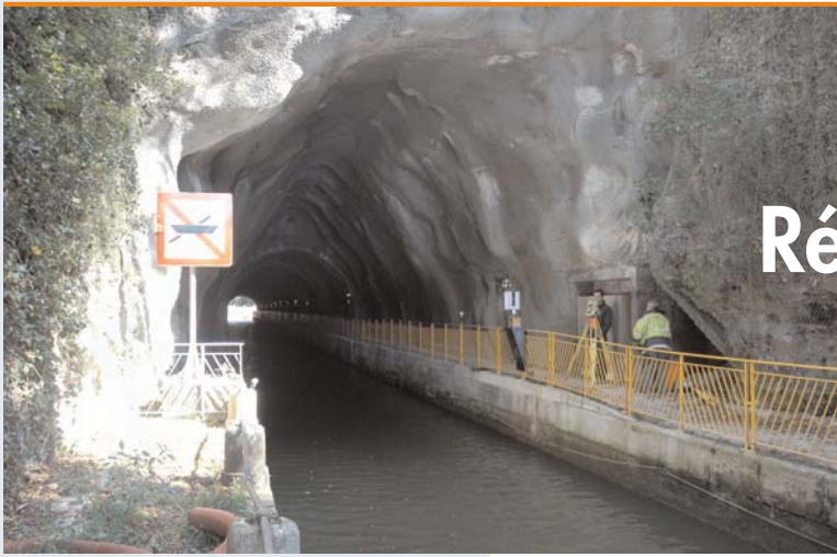
Photo 1 - Vue de la tête Aval du tunnel de Thoraise rénové
