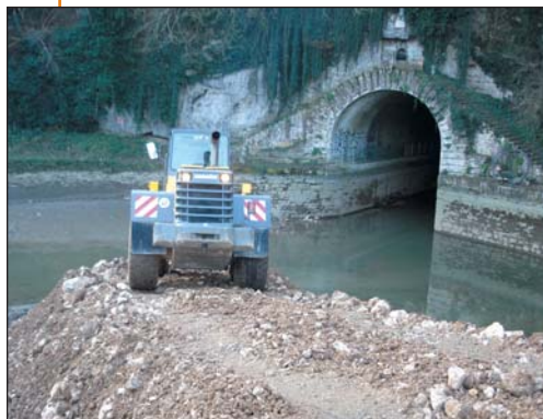
Photo 4 - Installation du chantier à la tête Amont
