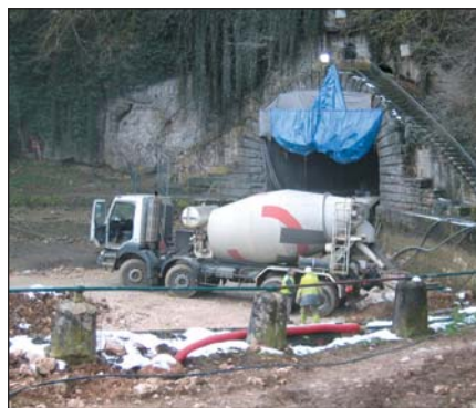
Photo 6 - Phase bétonnage - tête Aval
